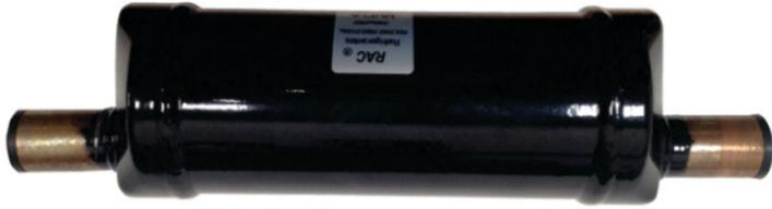
Uma mufla deve ser colocada logo após o flexível em cada linha de descarga.
